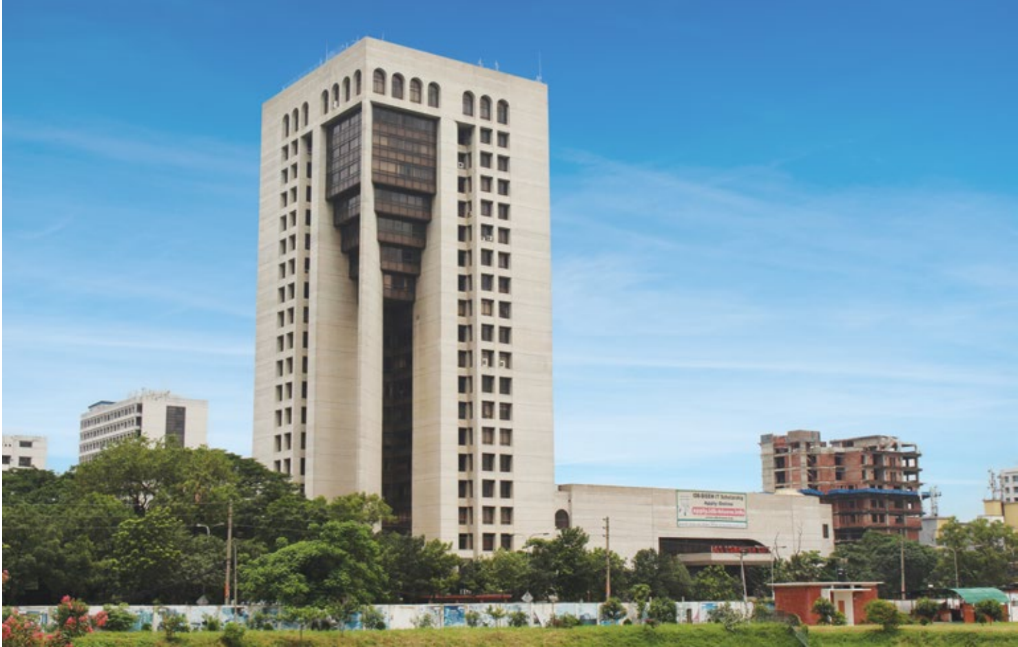
المصدر: صندوق ترميم ممتلكات الأوقاف
